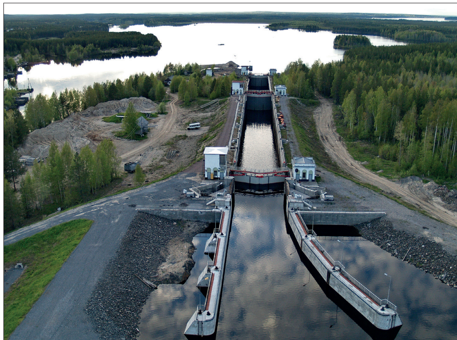
Schleuse Nr. 1 Weißmerkanal
